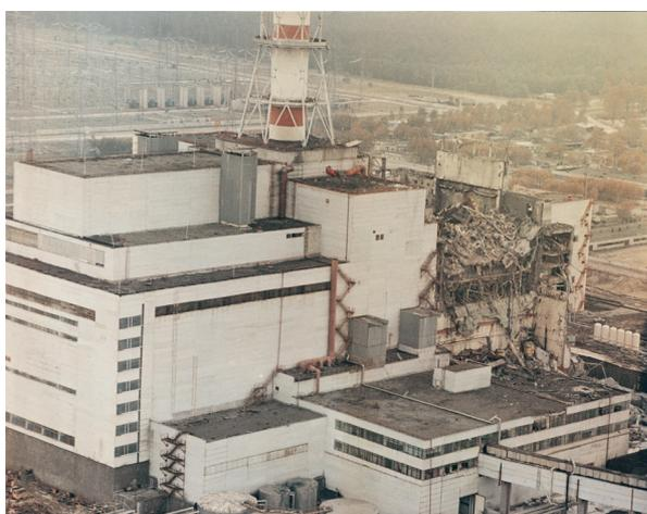
Рисунок II.1 Разрушенный реактор
